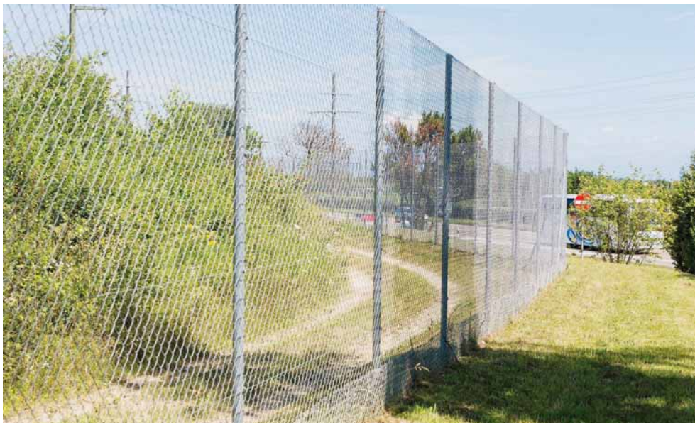
Hautes de 2 mètres, les barrières (ici à l'aire de repos de la Pierre-Féline), empêchent désormais les cerfs de se retrouver sur l'autoroute. GLENN MICHEL
