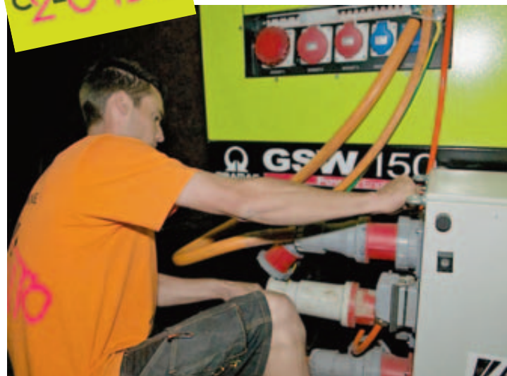
Lionel Sauty simule une panne d'électricité. La génératrice de secours prend le relais en moins de deux secondes. Test réussi. CÉDRIC SANDOZ
