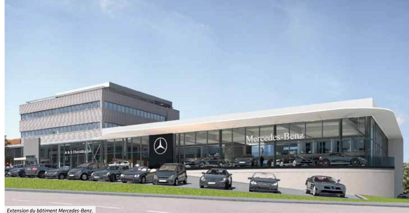
Extension du bâtiment Mercedes-Benz.
